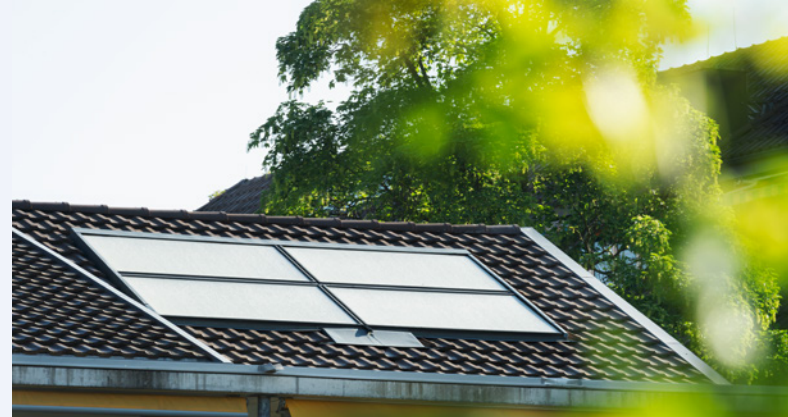
Solarkollektoren versorgen das Haus mit Warmwasser.
