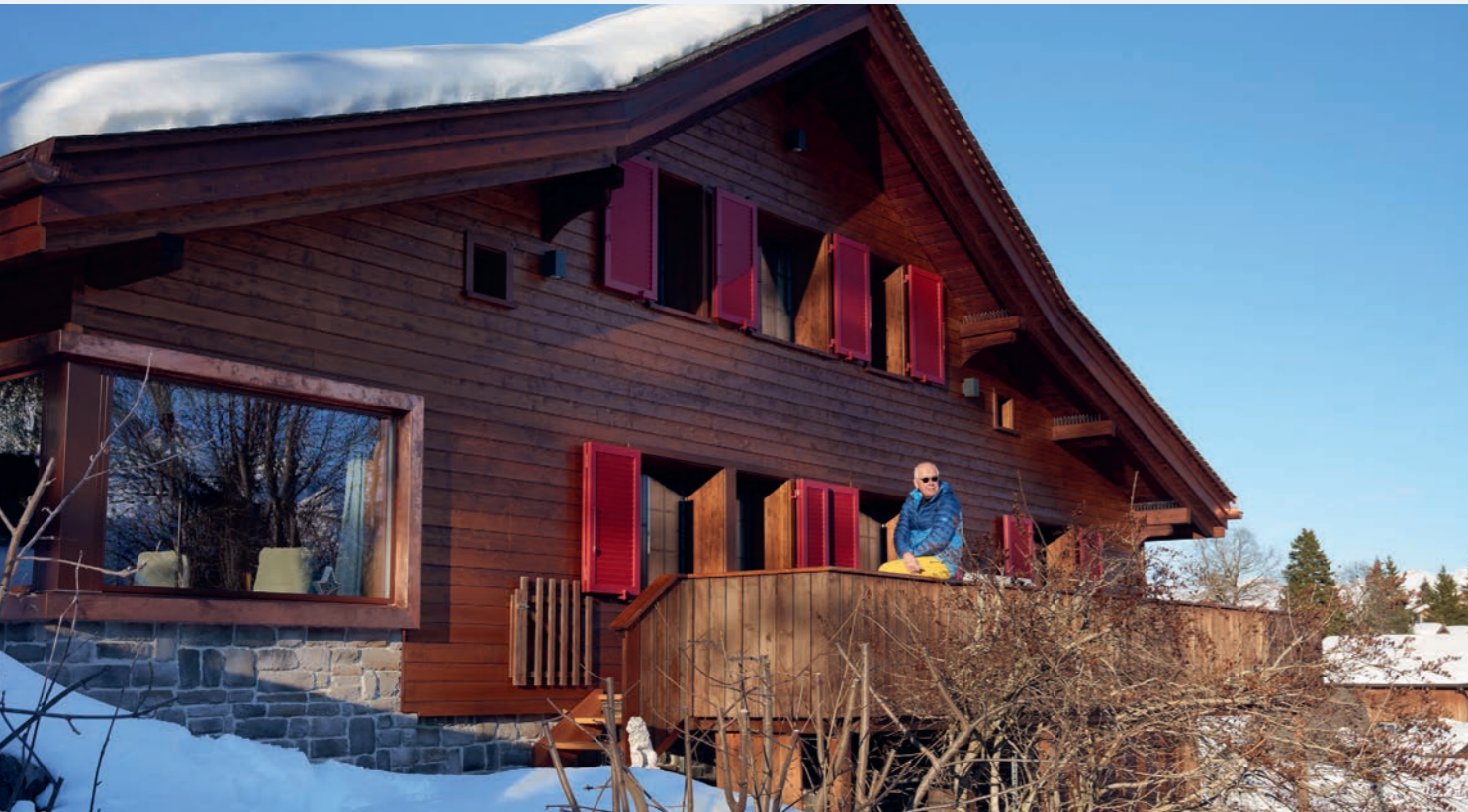
Michael Ladwig vor dem sanierten Chalet
