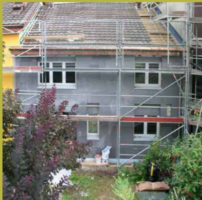
L'insediamento del 1983 Durante i lavori di risanamento
