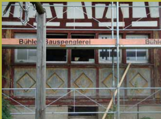
Dettagli che necessitavano di un risanamento
